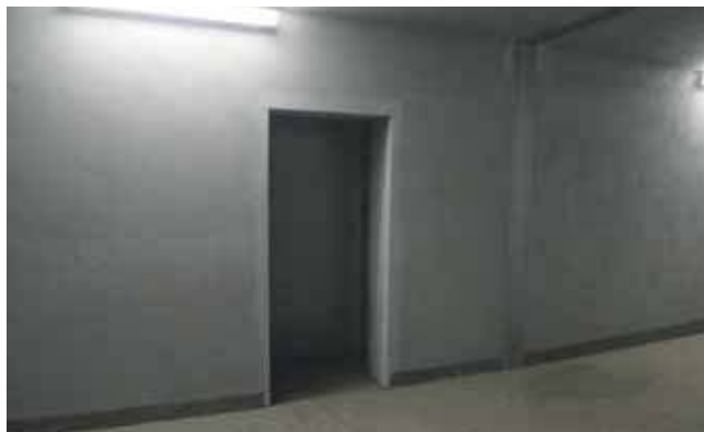
Wejście do klatki schodowej, która łączy tunel z terenami kolejowymi. To między innymi jej budowa przeciągnęła termin oddania inwestycji
