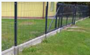
❸ W bocznym odcinku ogrodzenia zamontowano przesuwную bramę 4 m.
