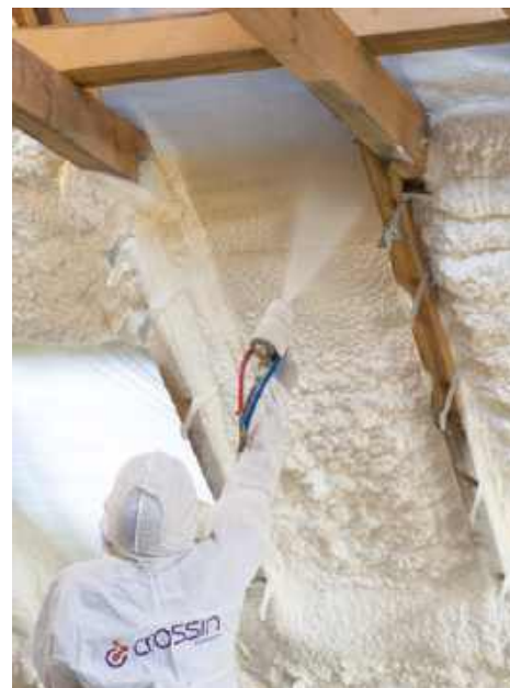
Ocieplenie dachu pianką PUR metodą natryskową. PCC PRODEX
