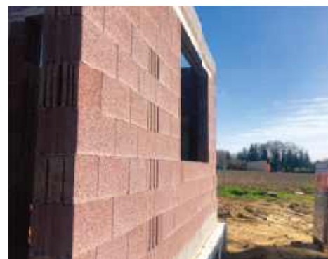
🔑 Keramzytobeton ma własności użytkowe podobne do ceramiki – jest niepalny, mrozoodporny, dobrze akumuluje ciepło i skutecznie chroni przed hałasem. CZAMANINEK
