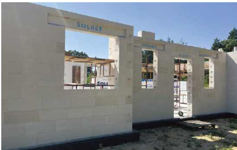
🔑 Dzięki porowatej i jednolitej strukturze beton komórkowy ma bardzo dobre właściwości termoizolacyjne. SOLBET
