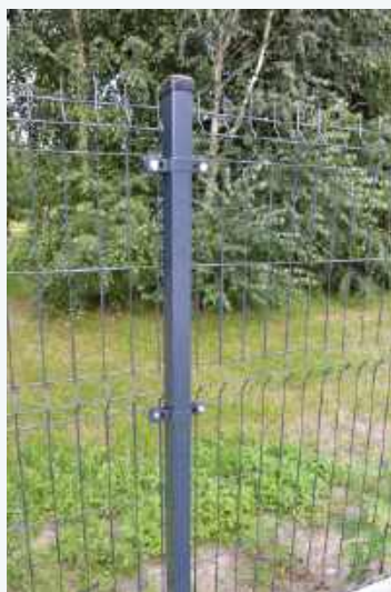
❶ Słupki osadzono na głębokości 50 cm, gotową podmurówkę płytą zagłębiono.
