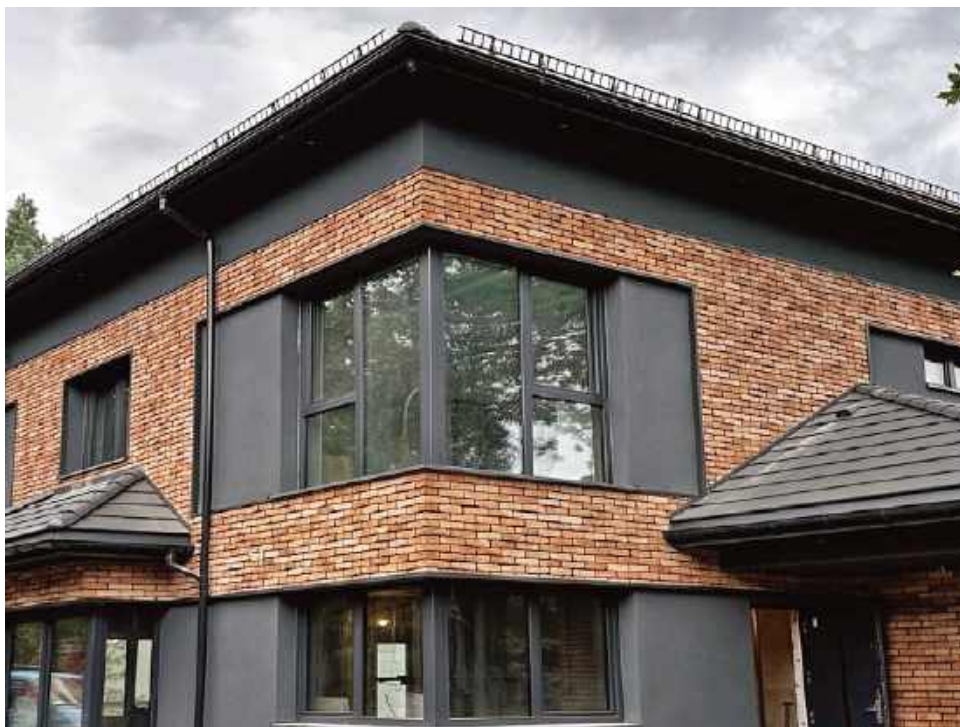
🔗 W nowoczesnej elewacji materiały mogą służyć do podkreślania podziałów bryły. Tutaj płytki elewacyjne o wyglądzie cegły zestawiono z grafitowym tynkiem, ciemną stolarką i dużymi przeszkleniami, uzyskując wyraźny kontrast faktur i kolorów. ELKAMINO-DOM
