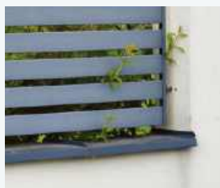
Na tynku z farbą fasadową uwiidacznią się szare zacieknięcia, na przęsłach występuje blaknięcie farby.
