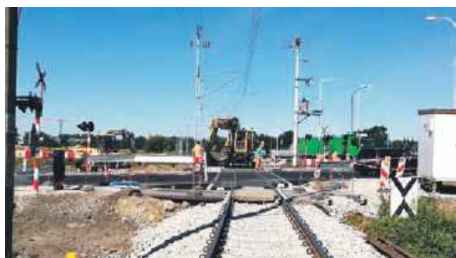
Zakończył się kolejny etap prac przy rewitalizacji linii kolejowej
