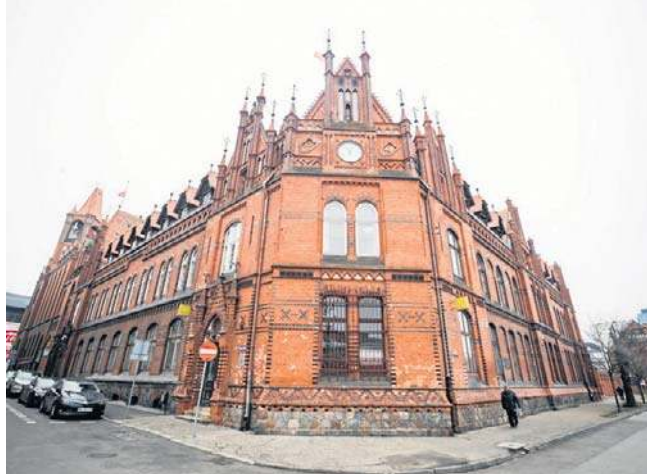
Neogotycki ceglany obiekt powstał w latach 1883-1899. Zachował się w stanie prawie niezmiennym do dzisiaj
