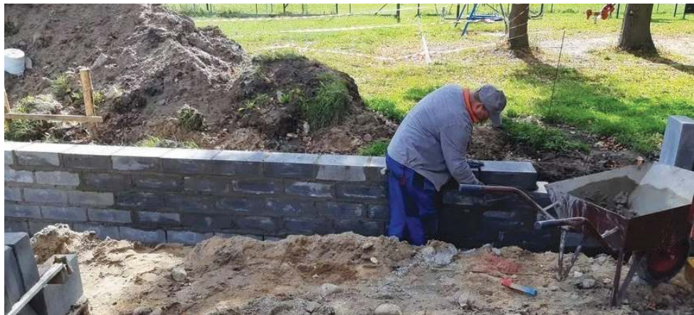
Prace przy strażnicy w Rębkowie
