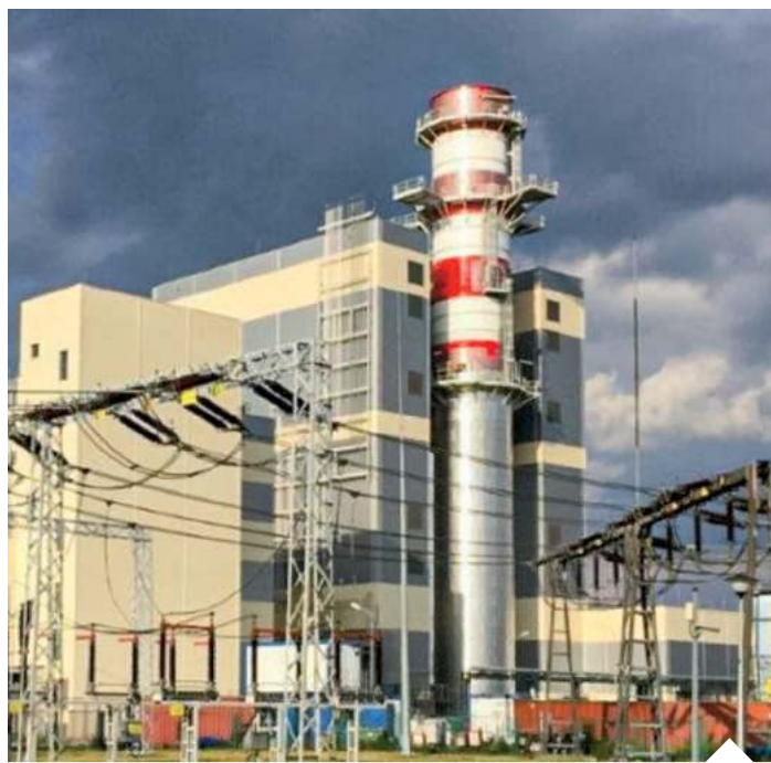
Oddany blok to element transformacji energetycznej Polski | fot. mat. pras/d
