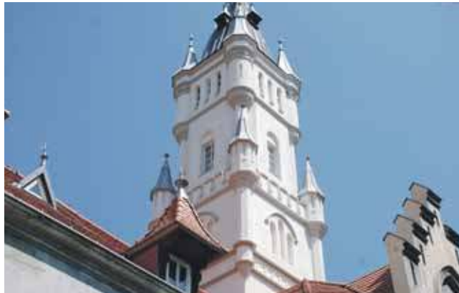
Remont wieży pochłonął 1,5 mln zł. Prace w całości sfinansował powiat
