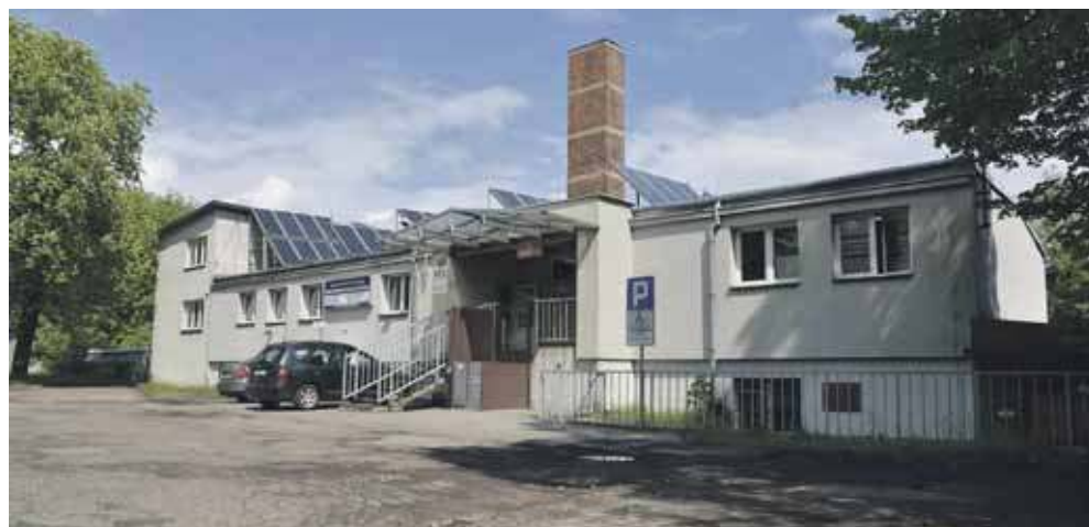
Ponad 600 tysięcy złotych otrzyma szpital powiatowy na modernizację przychodni przy ul. Opolskiej 21 w Tarnowskich Górach
