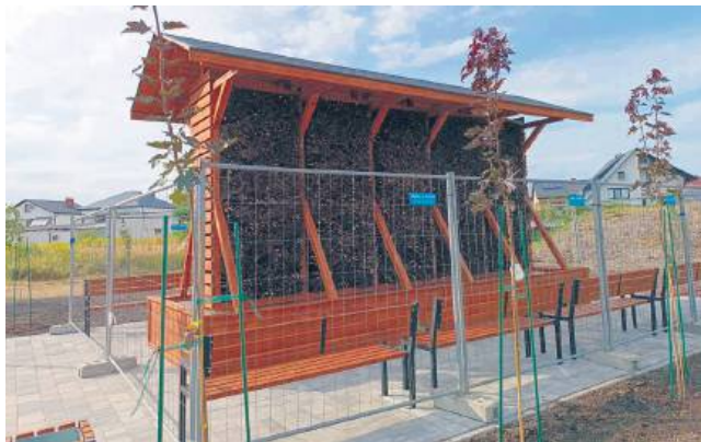
Tężnia solankowa to zadanie wykonane w ramach ubiegłorocznego budżetu obywatelskiego.
