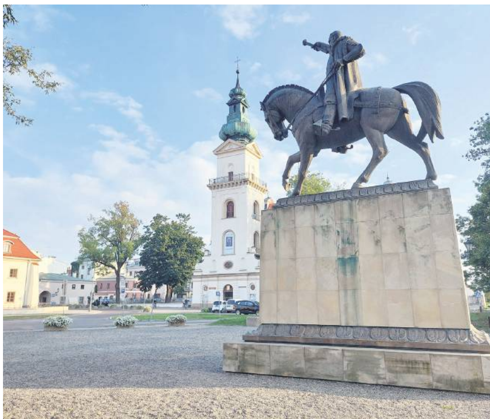
Na cokole jest coraz więcej zabrudzeń i zacieków.
