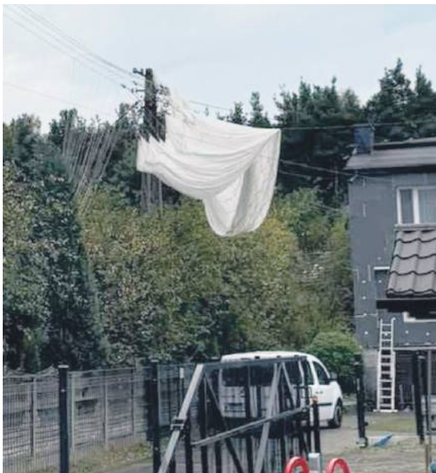
Wezwani na miejsce strażacy usuwali spadochrony z budynków i linii energetycznych. Fot. OSP Chechło
