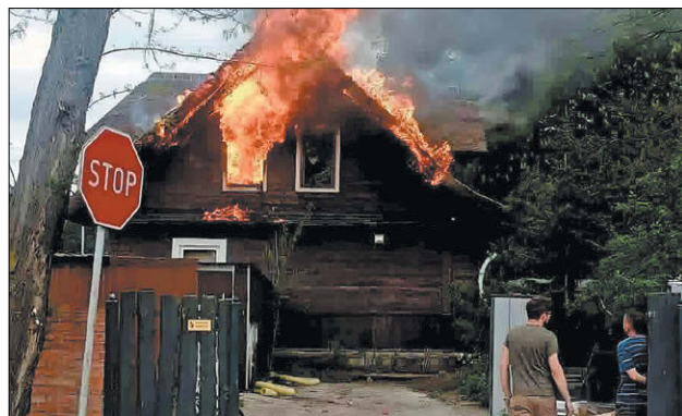
Ogień zniszczył dach i elewację drewnianego domu
