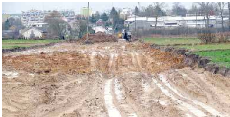
Prace już trwają
