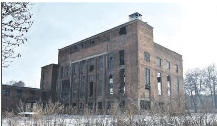
Dziś obiekty po ciepłowni to tylko gołe ściany
