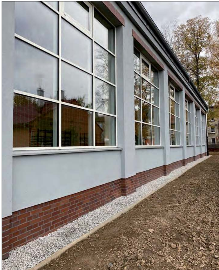
Oprócz ocieplenia budynku wymieniono również wszystkie okna
