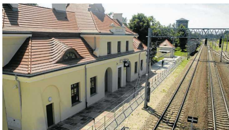
• Budynek dworca kolejowego w Modlinie FOT. PRZEMEK WIERZCHOWSKI / AGENCJA WYBORCZA.PL
