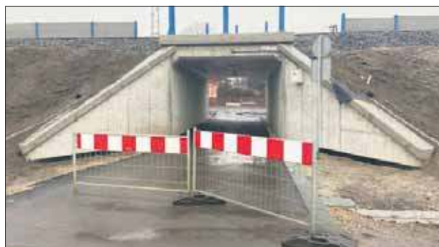
Przejście pod wiaduktem działa od grudnia
