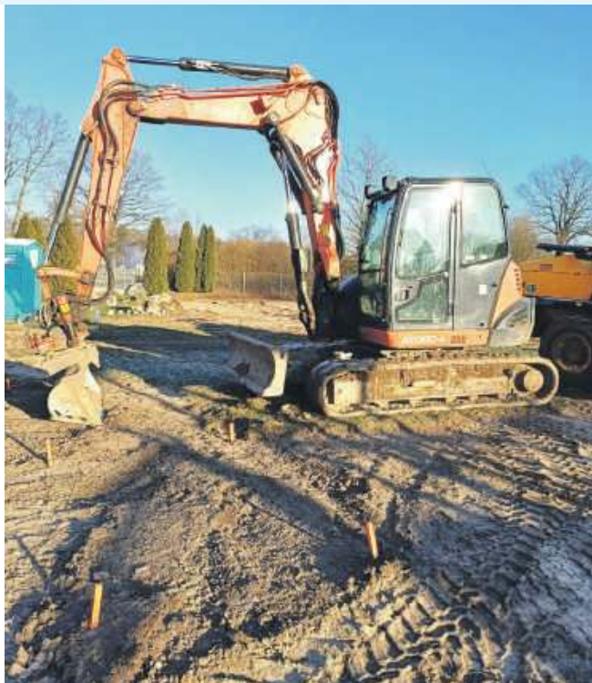
Rozpoczęcie budowy skate parku w Strzeszowie
