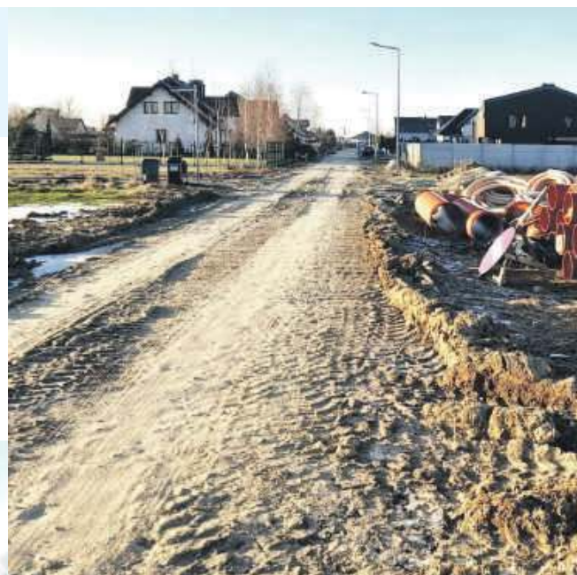
Przebudowa ul. Wiosennej w Krynicznie
