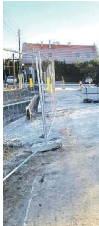
Przebudowa mostu w Strzeszowie
