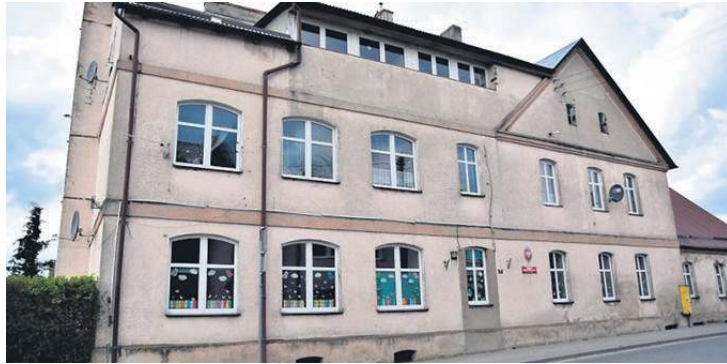
Budynek przez wiele lat służył jako przedszkole w Cekcynie.
