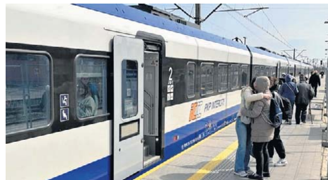
Przebudowa peronu i budowa przejścia podziemnego pod torami na stacji Tomaszów Mazowiecki
