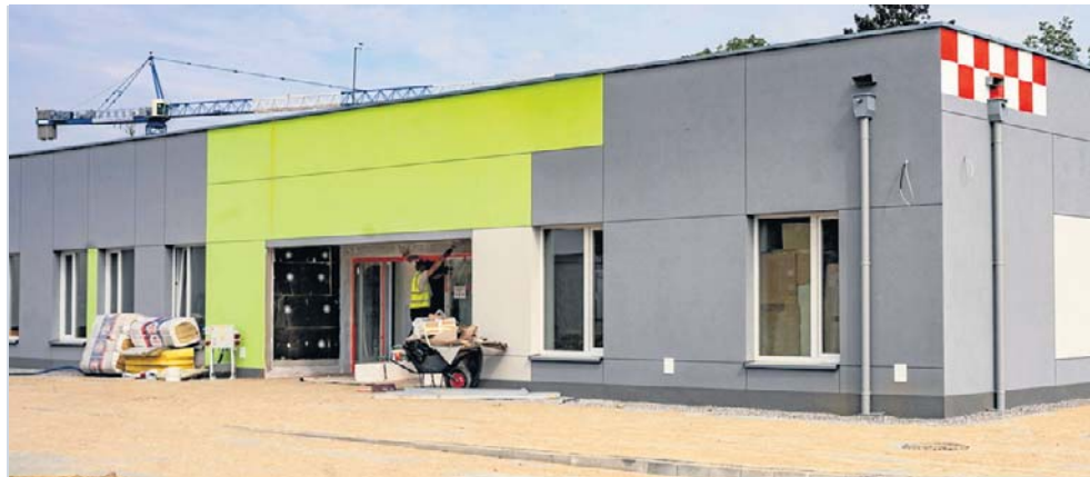
Prace przy budowie ZOL przebiegają terminowo
