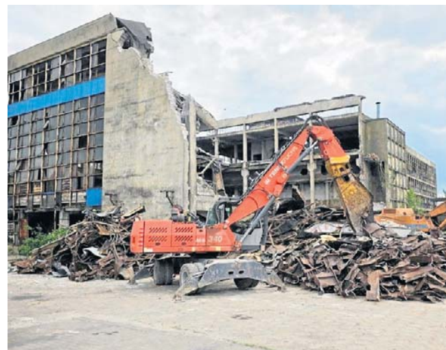
Wyburzanie budynków dawnej Huty Szkła Okiennego Kara w Piotrkowie Trybunalskim
