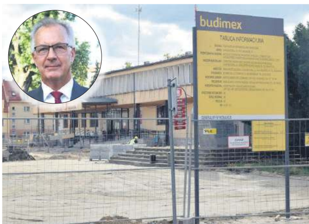
Władze samorządowe ogłoszą niebawem przetarg na termomodernizację oraz prace związane z budową wejść do siedziby magistratu.
