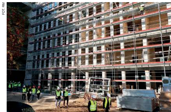
Pięciopiętrowy budynek Centrum Administracyjnego robi wrażenie...
