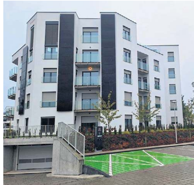
Jeden z budynków w kształcie oktagonu przy ulicy Grasera. Firma Urbański odebrała za tę inwestycję nagrodę
