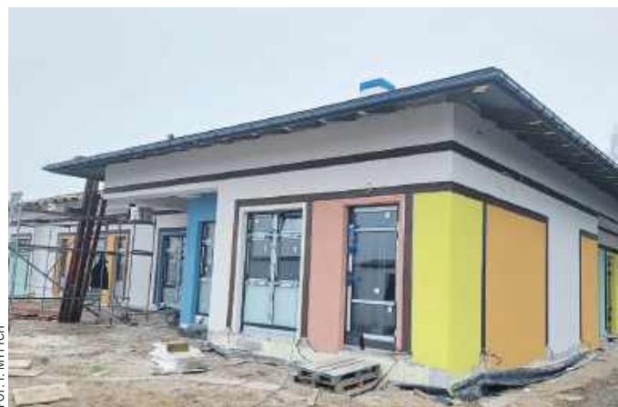
Budynek nowej placówki już został wzniesiony
