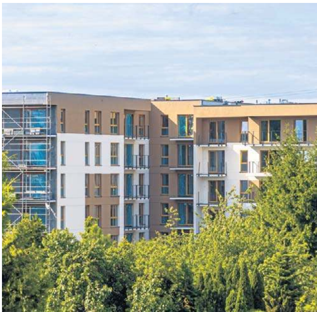
Przy ul. Telefonicznej 19 powstaje kameralna inwestycja Nova Radiostacja – 77 mieszkań i apartamentów (30–80 mkw.)
