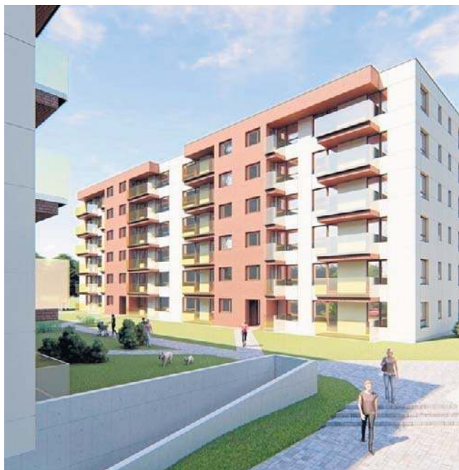
Na kompleks Wólczńska 248 składają się cztery budynki - dwa sześciokondygnacyjne, jeden cztero- i jeden pięciokondygnacyjny
