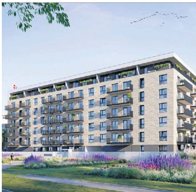
Przy ul. Smugowej 10/12 powstaje inwestycja Modern Helenów - w budynku podzielonym na trzy sekcje powstaną 234 lokale
