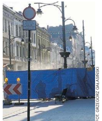
Trwa montaż słupków, unoszą się tumany kurzu
