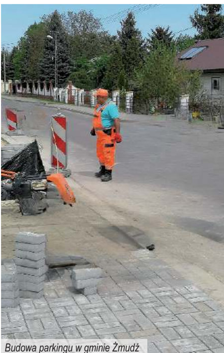
Budowa parkingu w gminie Żmudź
