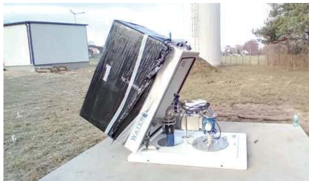
Nowa studnia ujmować będzie wodę z głębszego utworu kredowego na głębokości 96 m, co w znaczny sposób odciąży studnie nr 1 i 2 (fot. gmina Serokomla)
