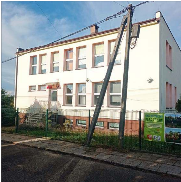
Miasto stara się o pieniądze na przebudowę tego budynku.
