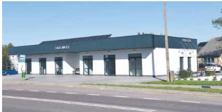
Nowy budynek przystankowo-usługowy w centrum Fajstławic
