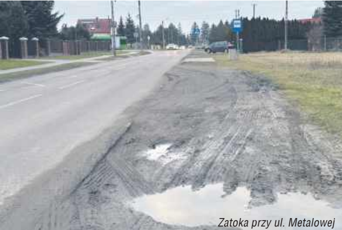
Zatoka przy ul. Metalowej
