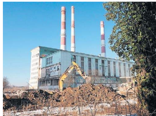
Rozpoczęła się rozbiórka dawnej elektrociepłowni EC2 przy ul. Wróblewskiego w Łodzi
