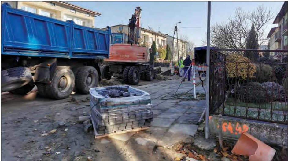
■ W tej chwili osiedle przypomina wielki plac budowy. Ulice są rozkopane, co na pewno nie ułatwia życia mieszkańcom
