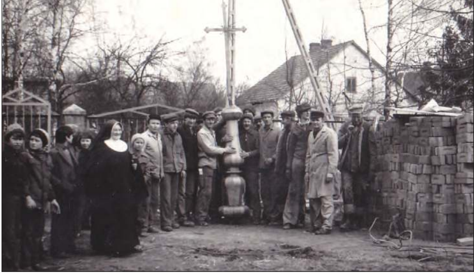
- To było pospolite ruszenie - mówi dziś Stanisław Durlej. W budowę nowej świątyni zaangażowali się parafianie. Nie szczędzili swoich rąk i maszyn do pracy. Na zdjęciu ze szczytową częścią wieży starego kościoła, która później została zainstalowana na wieżycie nowej świątyni
