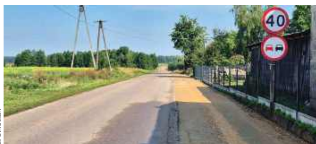
Przebudowa obejmuje trzy odcinki drogi o łącznej długości ponad 2,4 kilometra
