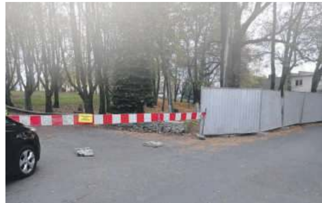
Płot stoi tylko na pewnym odcinku. Z pozostałych stron, na plac budowy można wejść bez problemu
