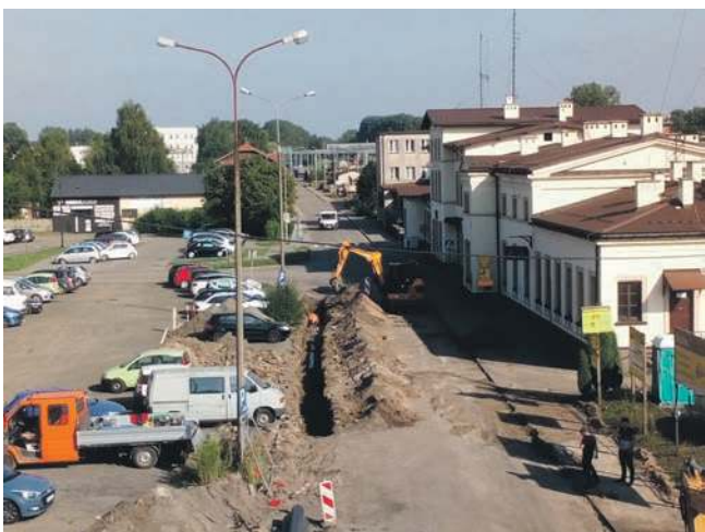
Na II etap przebudowy ul. Dworcowej gmina otrzymała dofinansowanie z Funduszu Dróg Samorządowych
