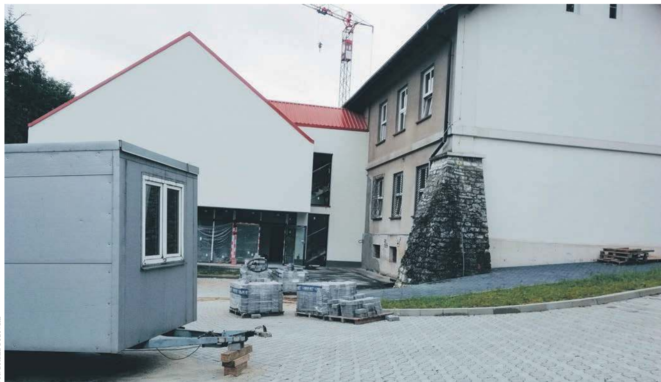
Główne wejście do szkoły w Grojcu, wraz z nową klatką schodową, będzie w dobudowanej części, od strony jaru
