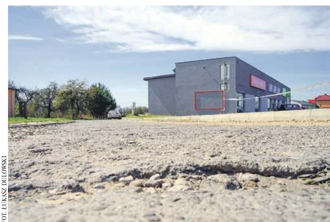
Spacerowa w Alwerni przed remontem
