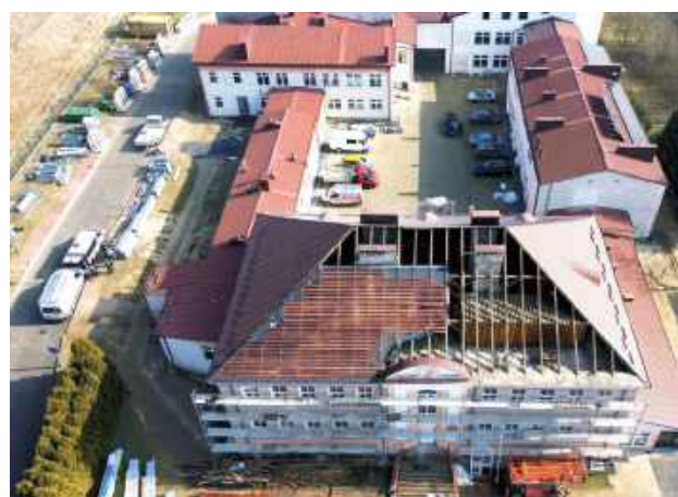
Wartość całej inwestycji opiewa na kwotę brutto 3.390.633,84 zł, a zakończenie realizacji planowane jest na 8 sierpnia
