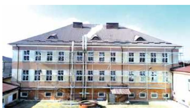
We Frampolu trwa remont budynku szkoły
