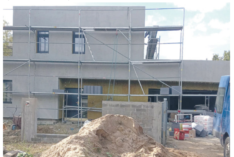
Budowa domu w Stoku Lackim
