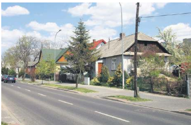
Przy ul. Młyńskiej nadal można oglądać wiele drewnianych domów.
