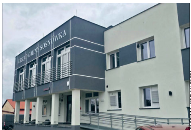
Inwestycja polegała m.in. na modernizacji budynku urzędu gminy
