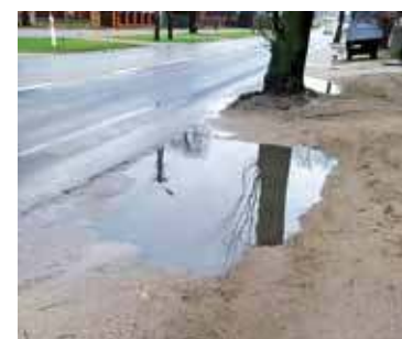
Spora kałuża pod którą znajduje się jedna ze studzienek kanalizacyjnych
