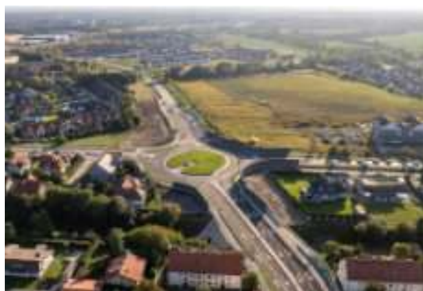
► Modernizacje i budowa kolejnych dróg Fot. UM Zabrze
