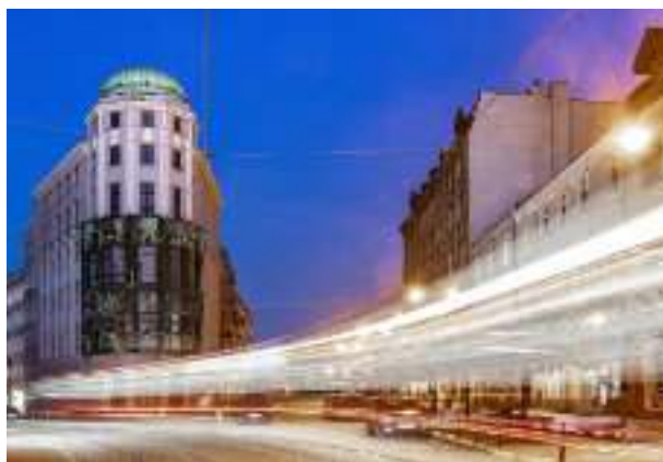
► Generalny remont dawnego hotelu AdmiralsPalast Fot. UM Zabrze
