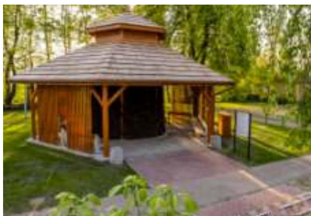
► Tworzenie tężni solankowych Fot. UM Zabrze
