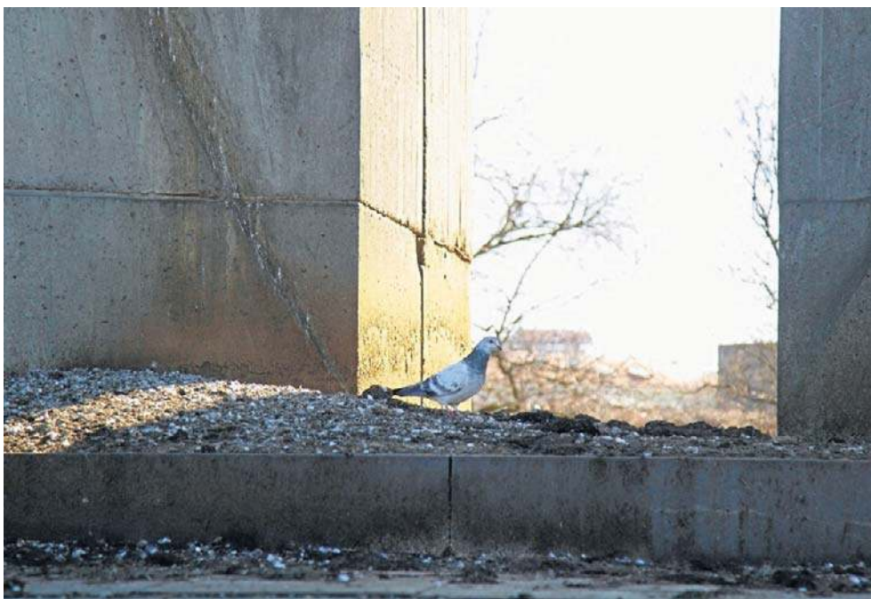
Nieuprzątnięty i popadający w ruinę pomnik
