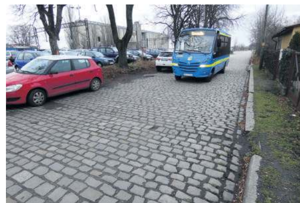
Gmina Strzelin ma w planach przebudowę i oświetlenie dalszej części ul. Bolka I Świdnickiego, która biegnie od dworca w stronę wiaduktu pod Szczawinem
