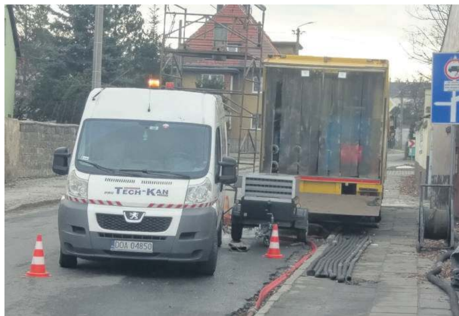
Na ul. Staromiejskiej w Strzelinie trwa renowacja kanałów
