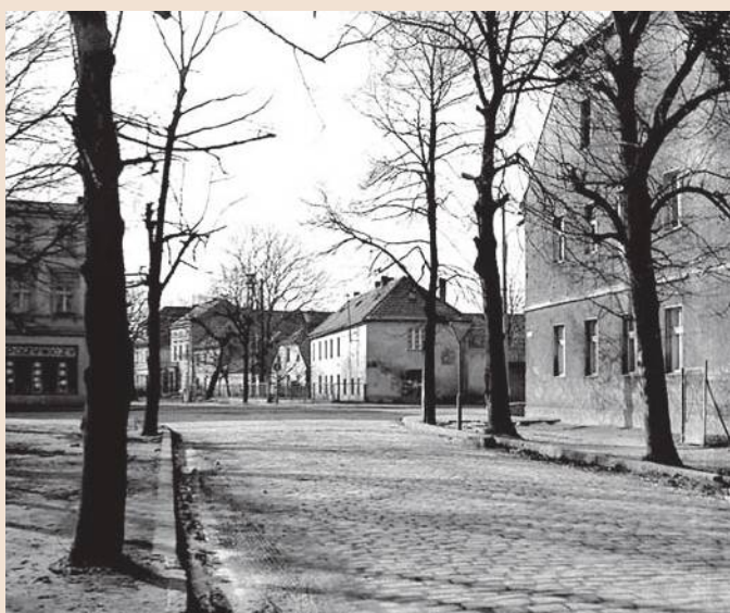
1975. To zdjęcie zrobiłem z ulicy Lipowej w kierunku ulicy Kutrowskiego. Po prawej widzimy budynek biurowy ZURB, w głębi nieistniejący dziś budynek, w którym była na parterze kuznia
