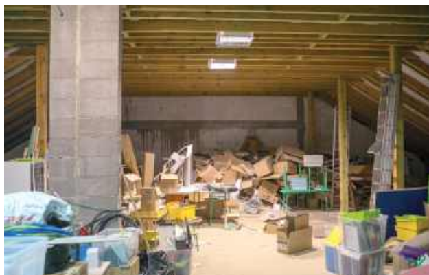
Jeszcze niezagospodarowane poddasze w szkole w Zofiówce
