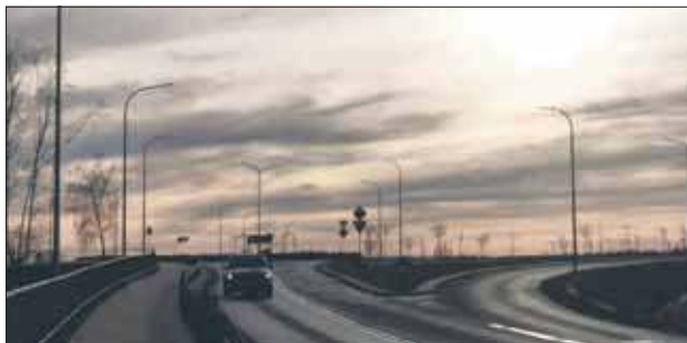
Awaria oświetlenia nastąpiła w wyniku burzy
