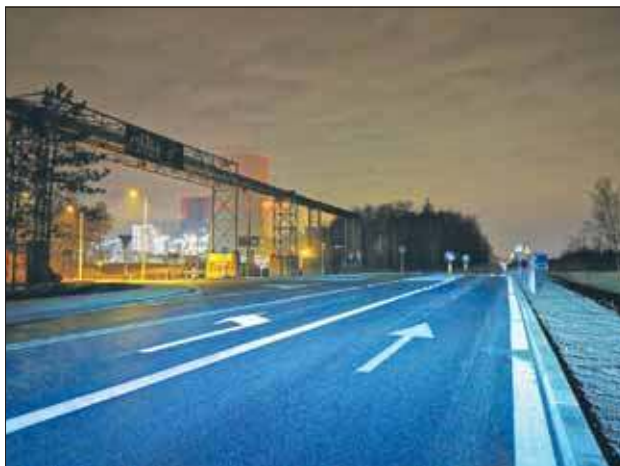
Na ul. Martyniaków powstał nowy przejazd kolejowy
