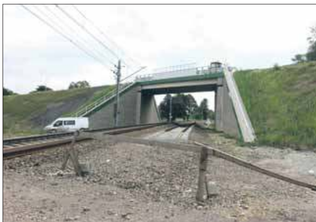
Wiadukt powstał w ramach modernizacji linii kolejowej E30
