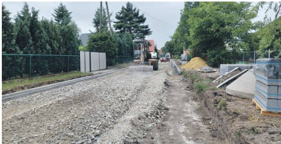
Trwają prace remontowe na drodze gminnej w Ludowie Śląskim
