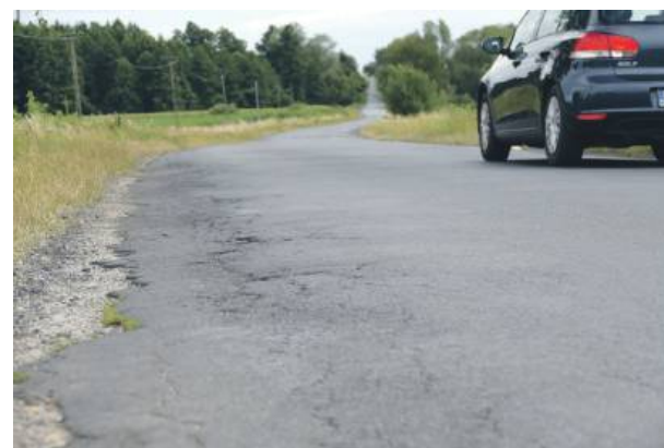
Jedną z remontowanych dróg ma być ta biegnąca między Krzywina a Przewornem
