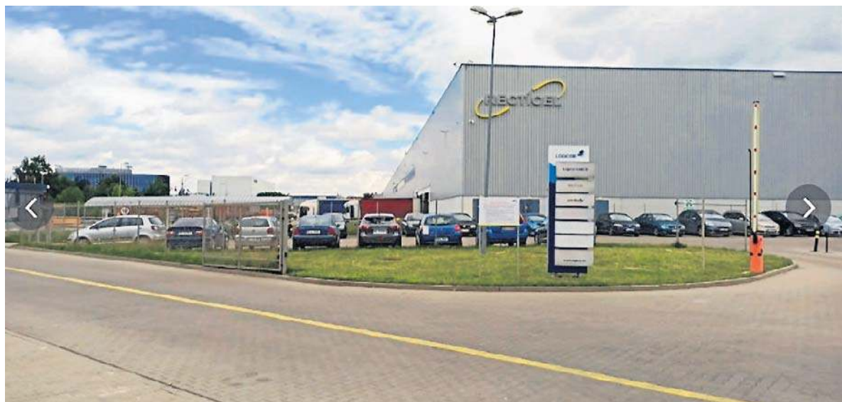
Zakład zlokalizowany przy ul. Granicznej od kilku miesięcy pozostaje zamknięty
