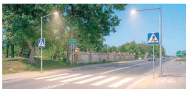
Tak będzie wyglądało przejście po przebudowie
