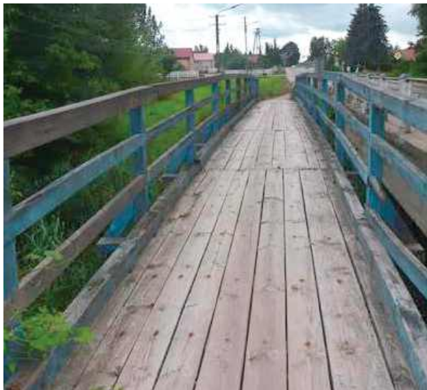
Stan kładki przed remontem
