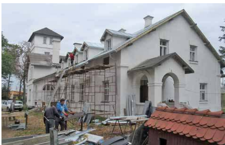
Właściciele już naprawiają dach
