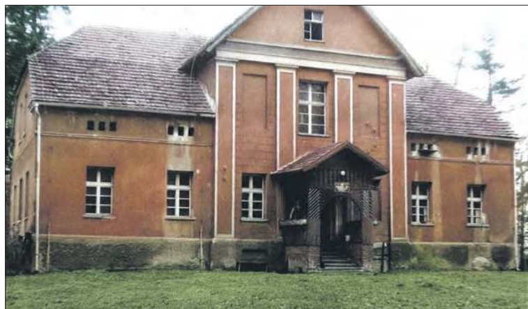
Pierwotna leśniczówka Oppersdorffów w ich dobrach nad środkowym biegiem Swornicy znajdowała się przy rozlewiskach między Posiłkiem a Kromolowem. Pod koniec XIX w. przeniesiono ją do lasu koło Brożca (Fazanica), co prawdopodobnie było związane z rozwojem wydobycia torfu w dotychczasowym miejscu. Po pięknym budynku leśniczówki pozostały tylko gruzy.
