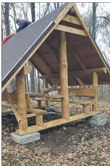
Wiaty na Długocie jeszcze w trakcie budowy
