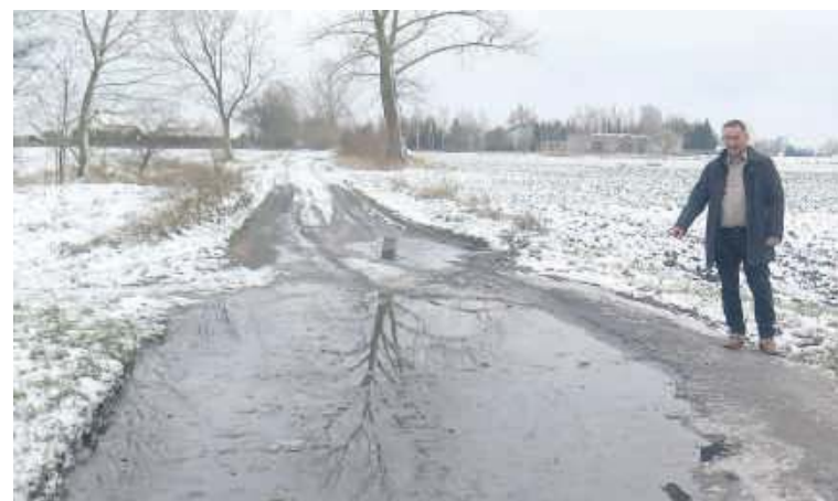
Maciej Komycz pokazuje tragiczny stan drogi w Nowej Wsi.
