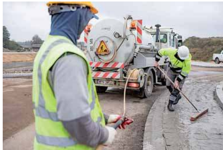
Budowa nowego węzła w Pieńkach
