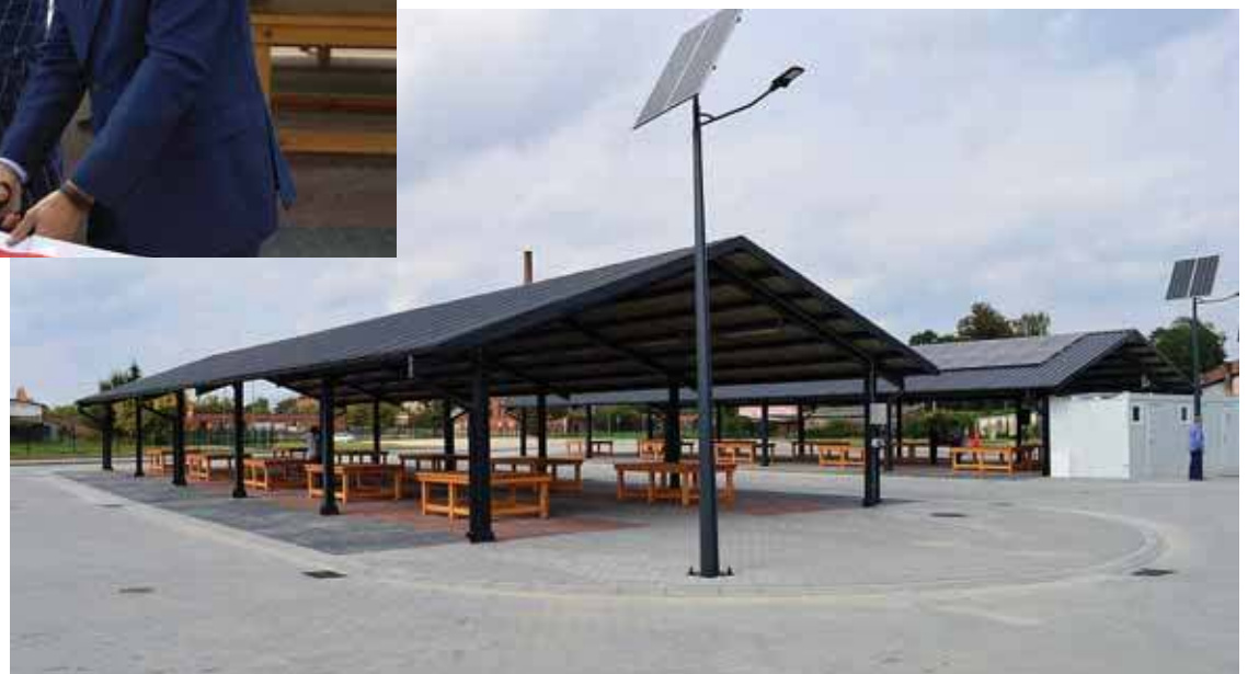
Zmodernizowany obiekt posłuży lokalnym handlarzom i społeczności.
