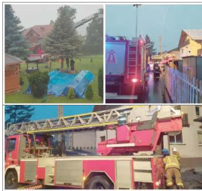
■ W Syryni strażacy zostali zadysponowani do uszkodzonych dachów przy ulicy 3-go Maja i Słonecznej. FOT. OSP SYRYNIA
